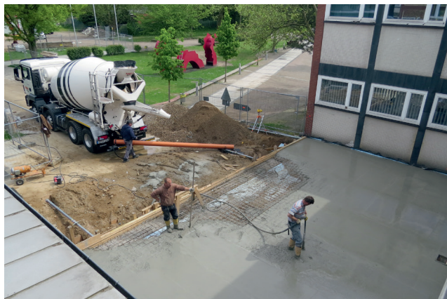
Ende Mai wurde das Fundament des Zubaus gegossen
